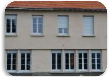
Des nouvelles fenêtres à l'école
