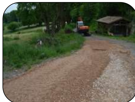
Un exemple de la voirie réparée
